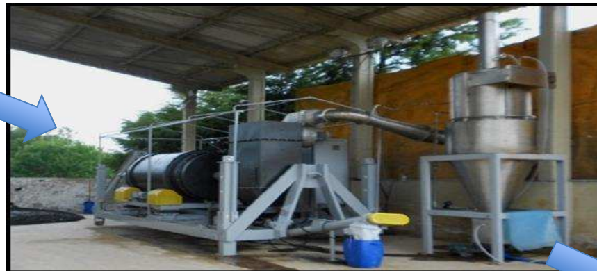
DRY SLUDGE (TS ~ 88 %)
