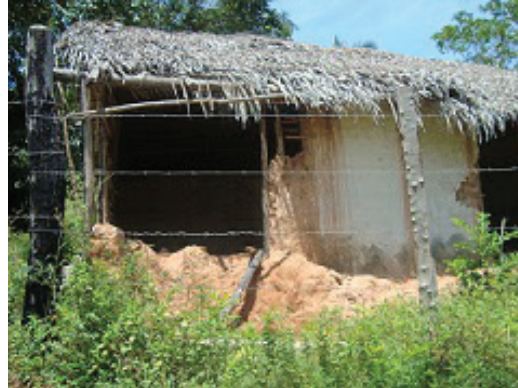
E.M Centro dos Cloves Despesas com Reformas 2012: R$ 52.548,97
